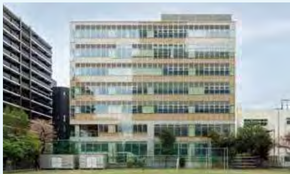
渋谷区子育てネウボラ (2021年 竣工)
