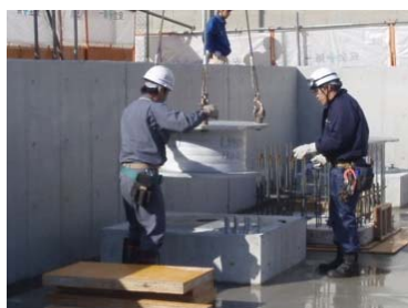
積層ゴム据付
