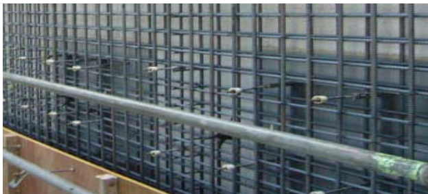
補強壁施工状況
