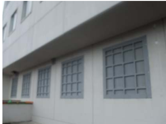
窓塞ぎ鋼板取付状況
